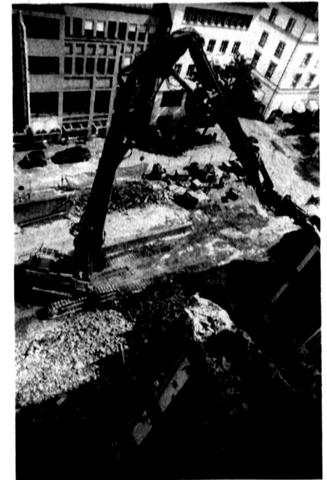
Gebäudeabbruch im Zentrum der Landeshauptstadt. Die Nachbarhäuser sind nur wenige Meter entfernt.
