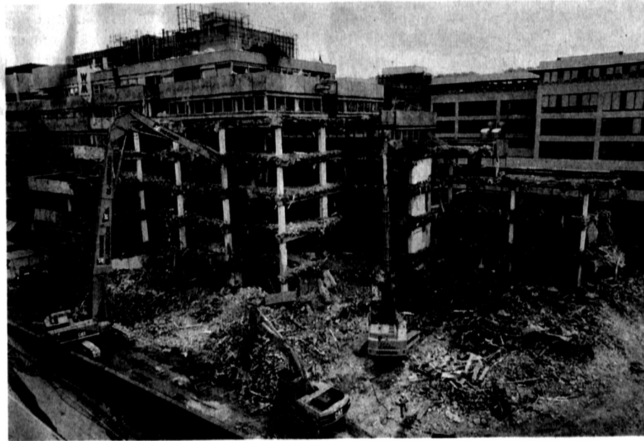
GL-Abbruch setzt am Kronprinzbau auf moderne Abbruchtechnik. Neben einer Vielzahl von Baggern, zwei davon in Longfront-Ausführung, kamen bei den Abbruchgeräten die Demarec-Systeme von Steck, Rammingen, zum Einsatz. Fotos: Steck/GL-Abbruch
