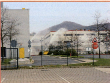
Die 11.000 m 2 Produktionshalle E 65 kurz vor der Sprengung.
