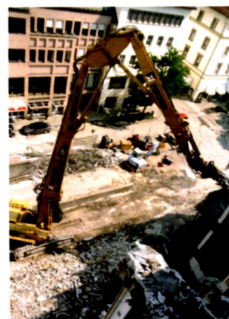
Gebäudeabbruch im Stuttgarter Zentrum: Die Nachbarhäuser sind nur wenige Meter entfernt.
